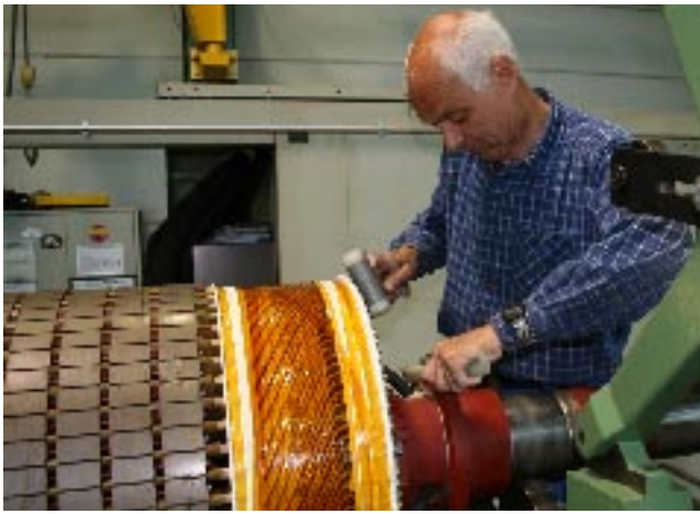
Ein Mitarbeiter setzt den Läufer eines 1,5-MW-Generators instand. Bandage und Anschlussleitungen sind erneuert, Ständer und Läufer neu gewickelt.
