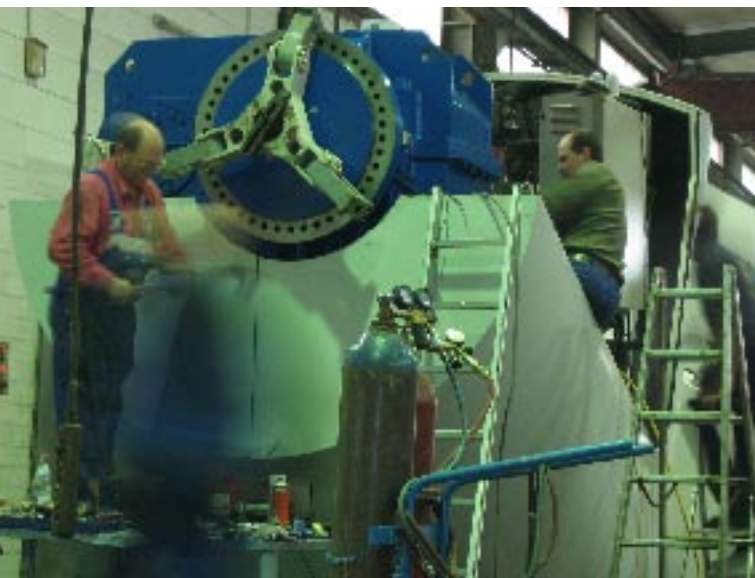
Mitarbeiter überholen im Werk eine komplette WEA-Gondel Fotos: Momac (2)
